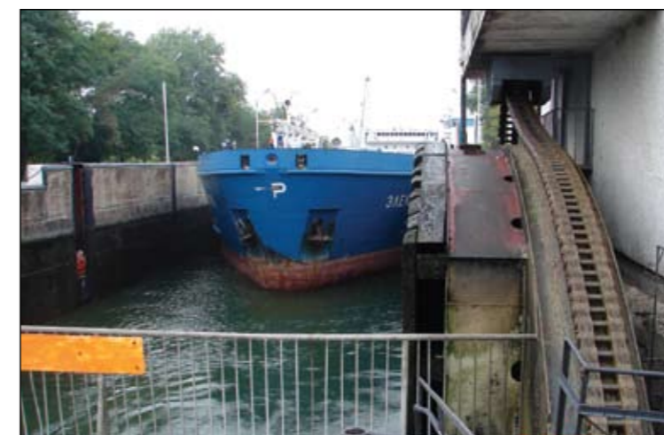
Рис. 3. Цепной привод сегментных ворот
