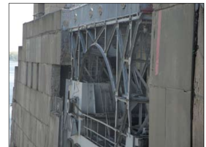
Рис. 4. Канатный привод двустворчатых ворот
