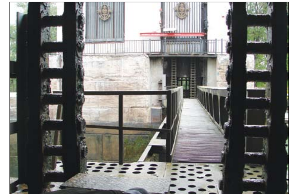
Рис. 2. Цепной привод подъемно-опускных ворот
