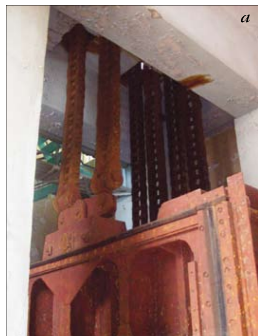
Рис. 1 (а, б, в). Цепной привод затворов водопроводных галерей нижних голов шлюза № 13-16 Городецкого РГСнС
